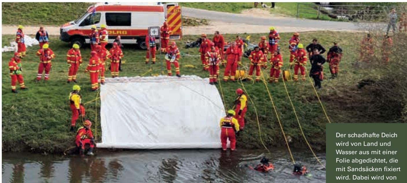
Der schadhafte Deich wird von Land und Wasser aus mit einer Folie abgedichtet, die mit Sandsäcken fixiert wird. Dabei wird von Land, am Wasser und auch unter der Oberfläche gearbeitet.
